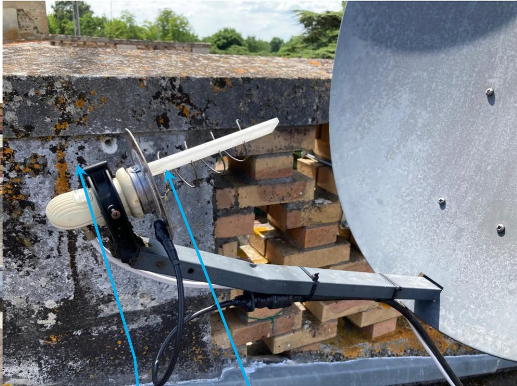
Un LNB (tête satellite TV) qui reçoit le 10 GHz et le transforme en 739 MHz
